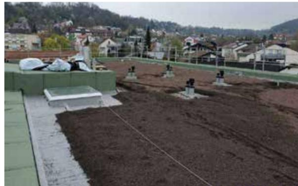
Das Dachsubstrat wird auf den Neubau Wiedenhöfer-Stift aufgetragen
